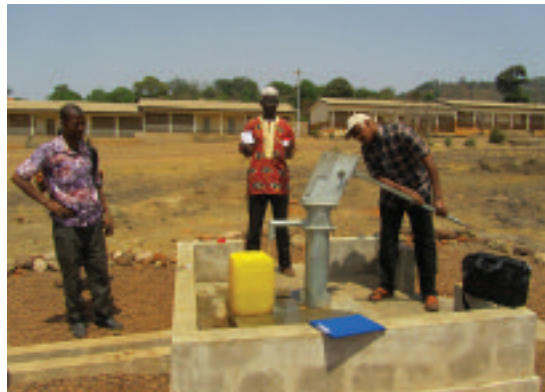
Figures 4 abcd Puits liés à des forages c: Avec serrure; d: Borne publique sur forage profond
